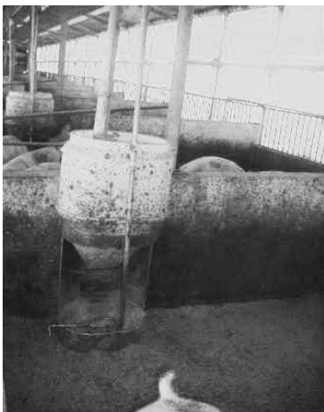
写真5 出荷中のエサの調整がうまくいっていない給餌器。これではもったいない限り
