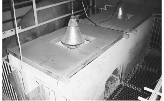
写真11 保温箱に天板をあと付けした
